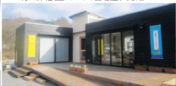
被災者のための岩手県大槌町 AMDA 健康サポートセンター。
