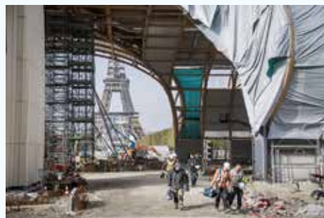
2024年パリ五輪の会場にもなる競技場の建設現場 2020年11月（EPA＝時事）
