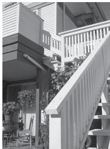
ベランダから庭への階段設置
