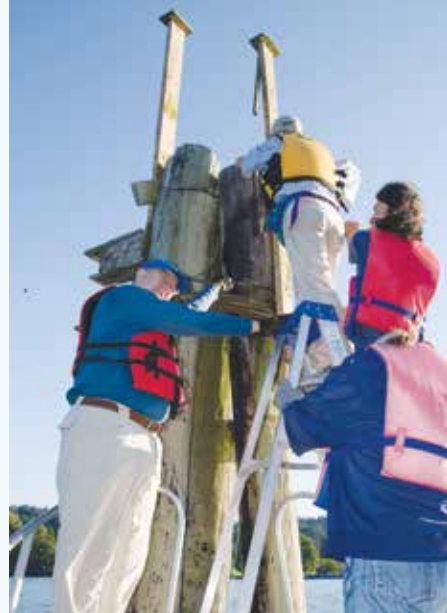
ボートの上から梯子作業
