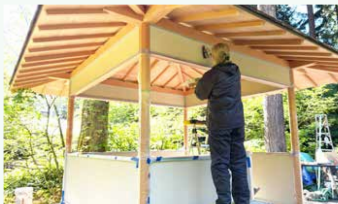
壁の仕上げ作業の様子
