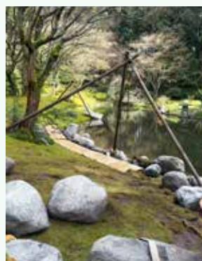
池護岸の石を据えている工程
