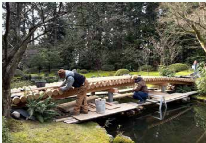
橋に用いる丸太の設置作業
