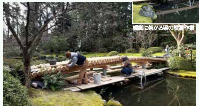
橋に用いる丸太の設置作業
