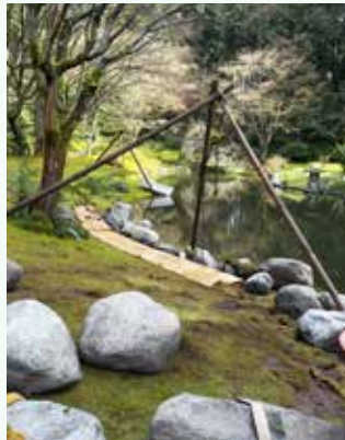
池護岸の石を据えている工程
