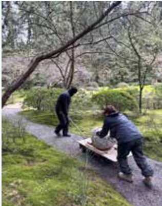
池護岸の石をすべて手作業で運搬する
