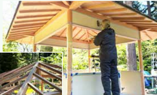
壁の仕上げ作業の様子
