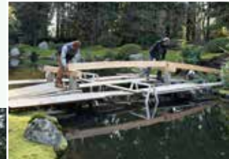
橋脚に架かる梁の設置作業
